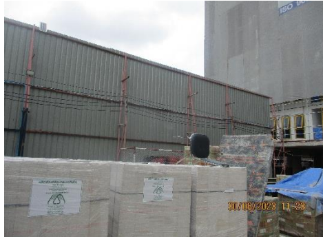
รูปที่ 13 ม่านละอองน้ำบริเวณรั้ว Metel Sheet
